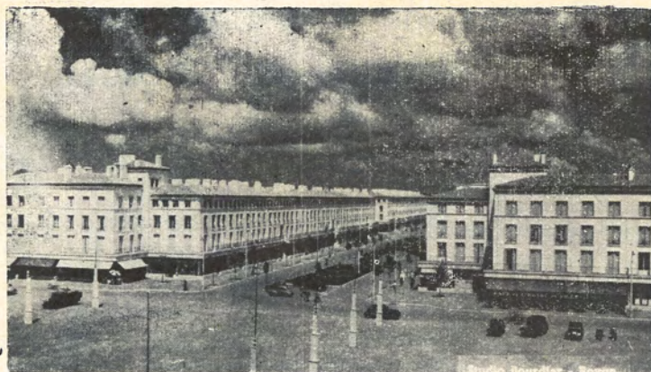
Royan - Boulevard Aristide-Briand
