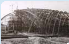
◀ L'ossature du coffrage
