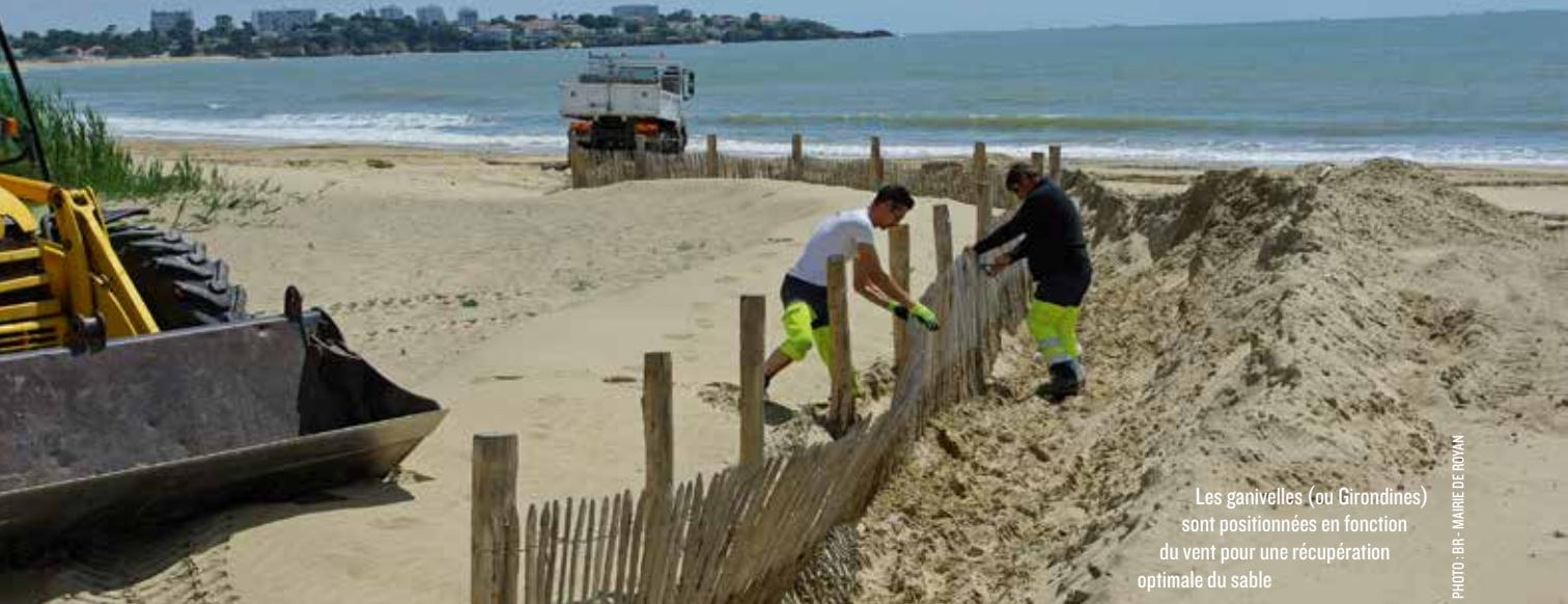
Les ganivelles (ou Girondines) sont positionnées en fonction du vent pour une récupération optimale du sable
